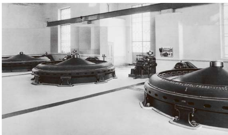
Elektrárna v Praze Na Štvanici (1929)
