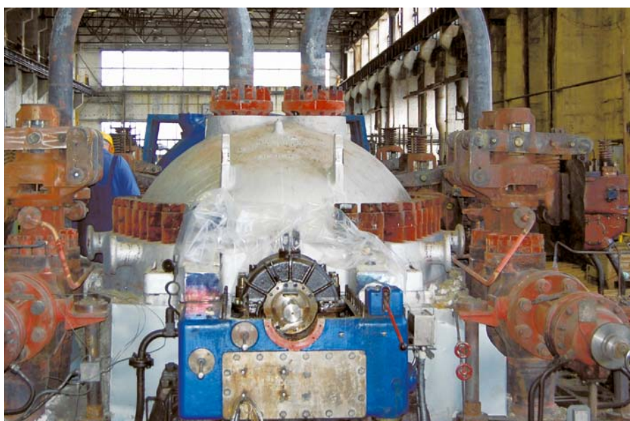
Příprava na svařování bloku TG2 v Teplárně Vřesová.
