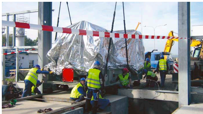
ČKD PRAHA DIZ v Třanovicích mimo jiné zajišťovala i kompletaci kompresorových soustrojí.
