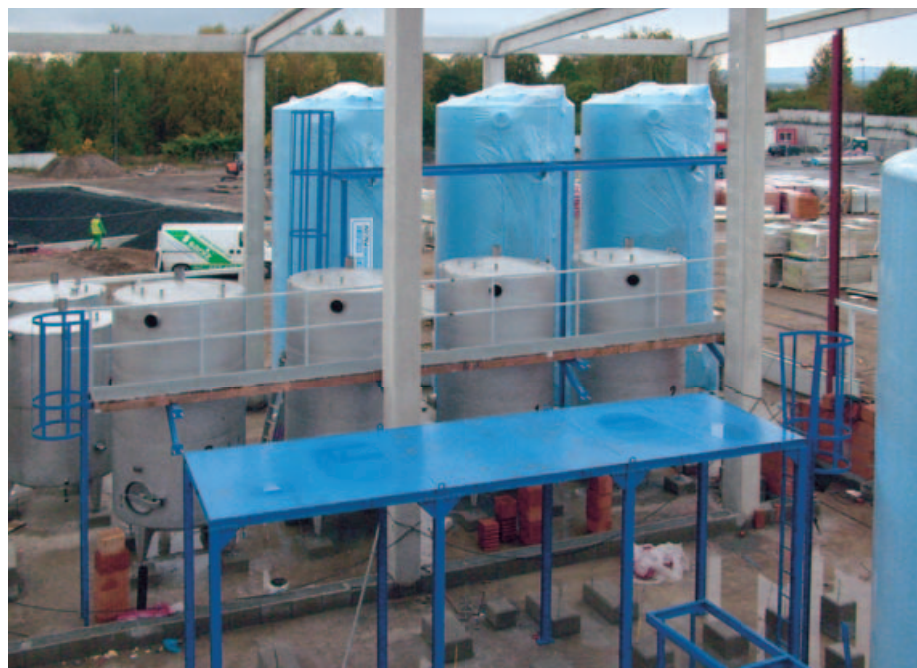
Instalace nádrží na becherovku z produkce Pacovských strojíren v novém závodě likérky v Karlových Varech-Bohaticích.
