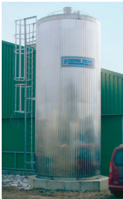
Venkovní silotank na mléko ve Zdislavicích má kapacitu 30 000 litrů
