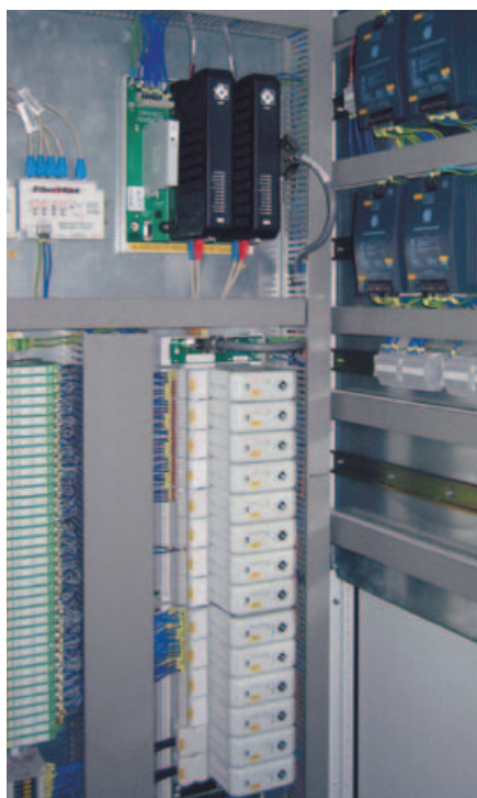
Předmět dodávky ČKD ENERGY – hardware primární regulace frekvence a monitoring hlavních signálů turbíny a ochrany kotle.
