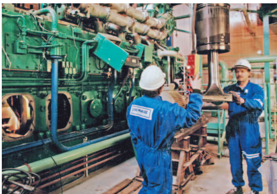
Velmi významný kontrakt pro celou skupinu ČKD GROUP na dodávku dieselgenerátorových stanic pro 3. a 4. blok JE Mochovce má hodnotu 880 milionů Kč. Obě stanice zákazníkovi – elektrárenské společnosti SE ENEL – předá ČKD PRAHA DIZ v roce 2012.
