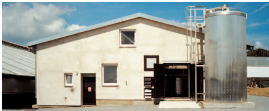
Instalace chladicího zařízení v Zemědělském družstvu Velká Chyška.
