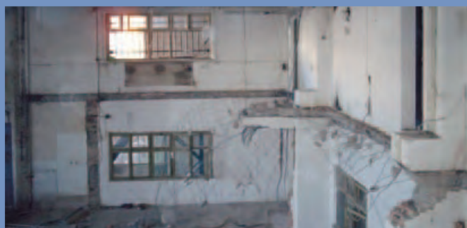
Stav budovy v roce 2006.
