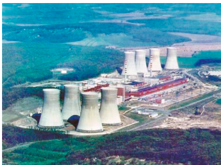
Více než 150 milionů Kč mají hodnotu rekonstrukce zařízení, které provádí ČKD PRAHA DIZ v JE Mochovce na blocích 1 a 2.
