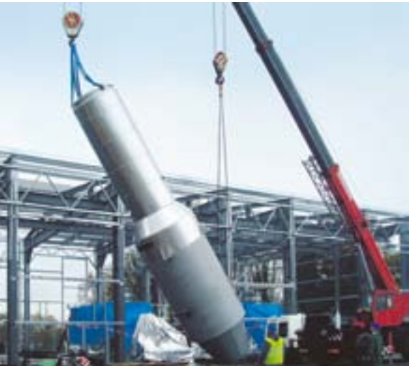
ČKD PRAHA DIZ zvládla i náročný transport všech stěžejních součástí do nové budovy kompresorovny.
