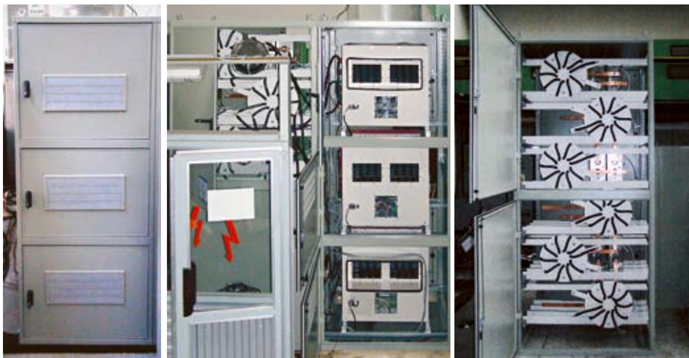
Zavřená a otevřená skříň střídače a skříň kondenzátorů.
