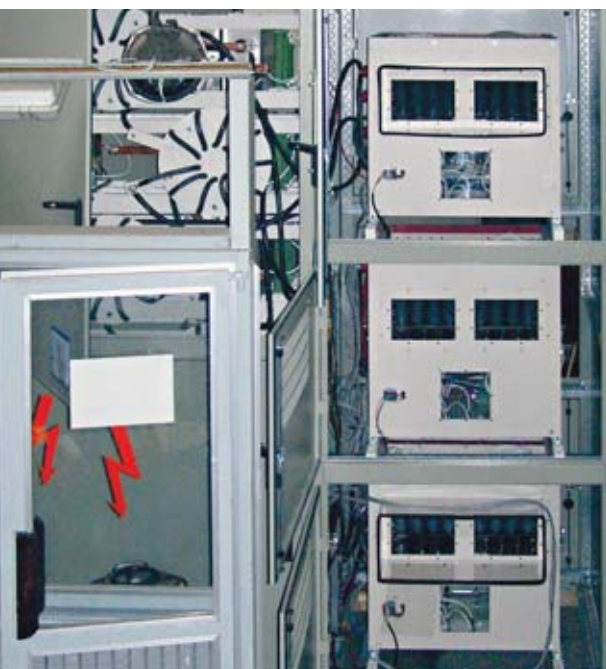
Закрытый и открытый шкаф инвертора и шкаф конденсаторов.
