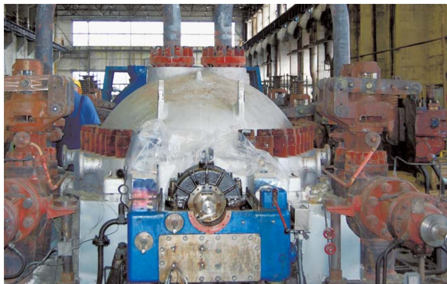
Подготовка к сварке блока TG2 на Теплоцентрали Вржесова.
