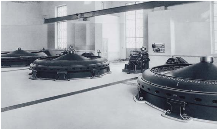
Электростанция в Праге, ул. Na Štvanici (1929)
