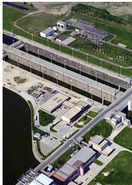
Pohled na plavební komory v Gabčíkovo, kde ČKD ENERGY provede do jara 2014 rekonstrukci dynamických ochranných zařízení.
