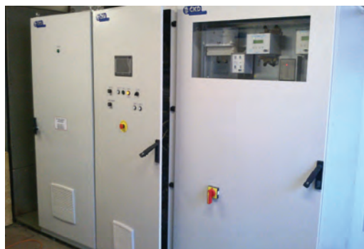
Budící zařízení značky ČKD tady bylo zprovozněno v září 2013.
