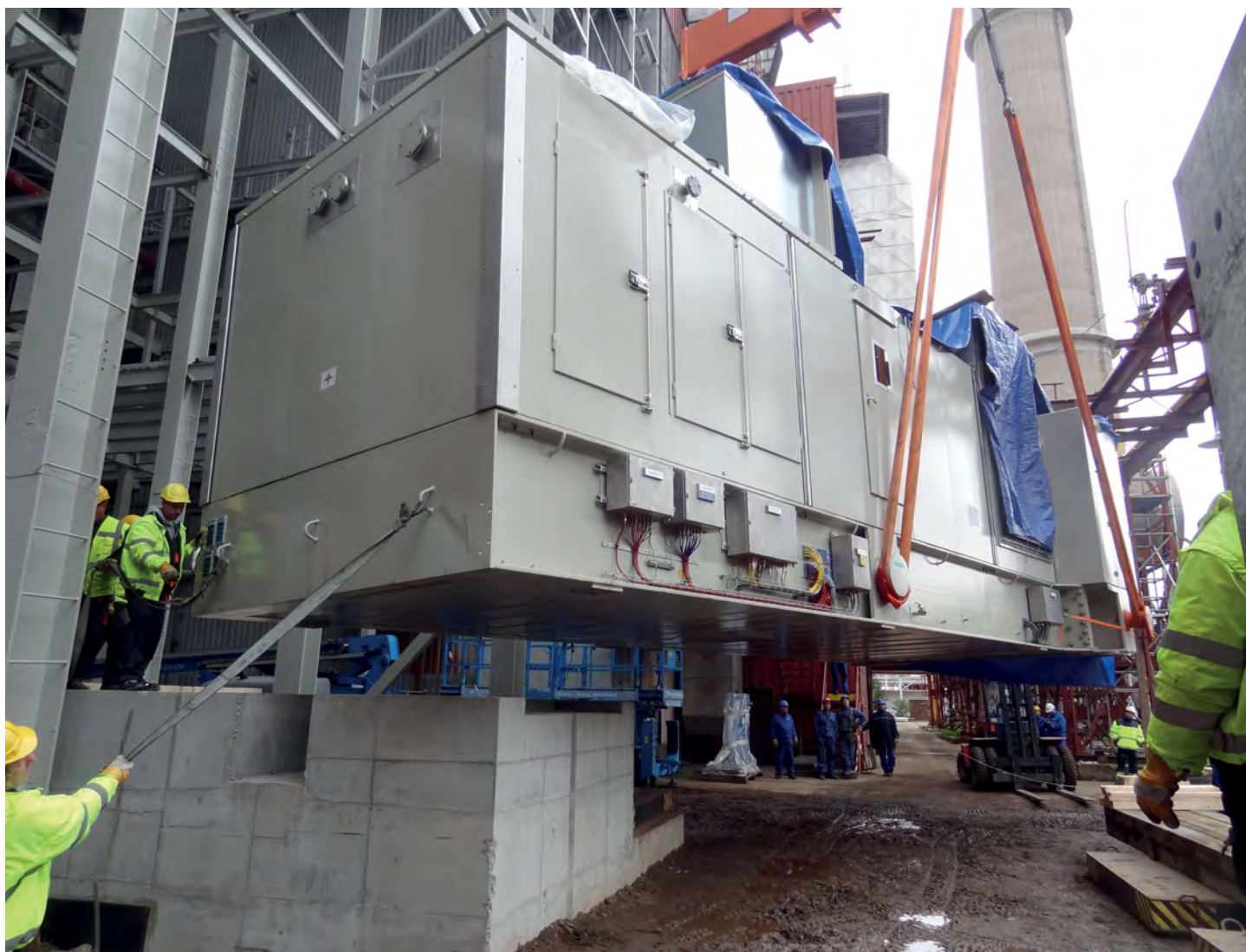
Zasouvání skidu plynové turbíny
