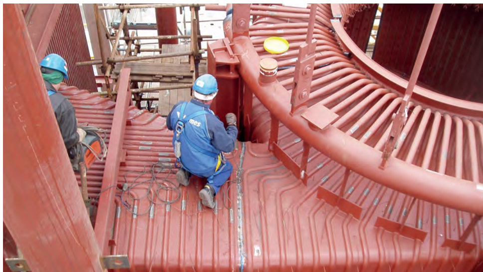
Svařování tlakových částí cyklonu a membránových stěn.
