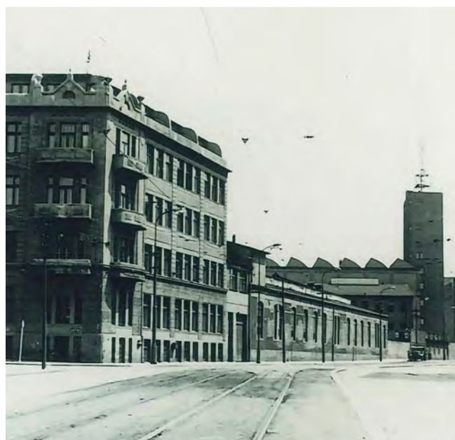
Pohled z náměstí OSN (dříve Lidových milicí) na někdejší areál ČKD Stalingrad (později Elektrotechnika) v Kolbenově ulici (tehdy Fučíkově). Vlevo administrativní budova, později projekce DIZu. Nízká budova za ní „Mědárna“ a střechy Transformátorů. Funkcionalistická věž vodojemu a tzv. jižní blok (vpravo).
